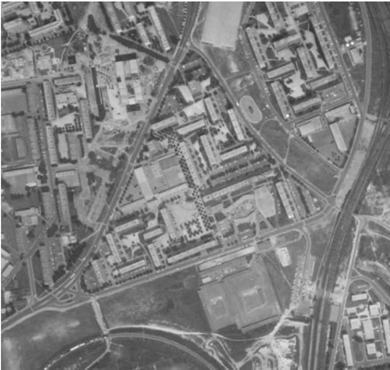
Photo aérienne 1974 –source : IGN
